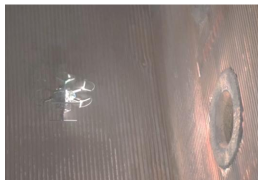
ボイラ炉内点検画像
