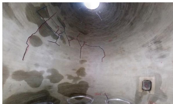
全天球カメラ撮影画像（煙突内部）
