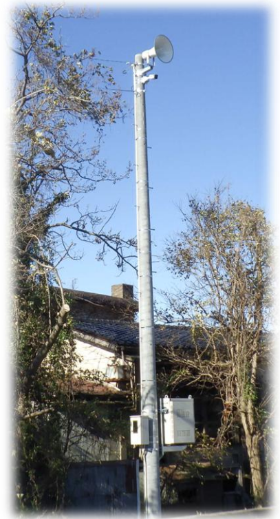
システム設置状況 (カメラ、スピーカ、システム収納BOX)
